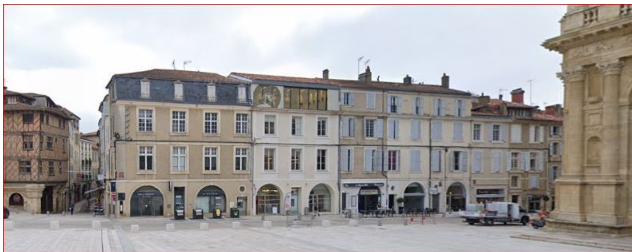
Fig .1 : Façades reconstruites vers 1682-1690 suivant des règles précises avec 2 étages aux fenêtres régulières et aux niveaux soulignés par un bandeau de pierres de taille. Au rez-de-chaussée, succession d'arcades pour les boutiques et de portes surmontées d'un œil-de-bœuf.
